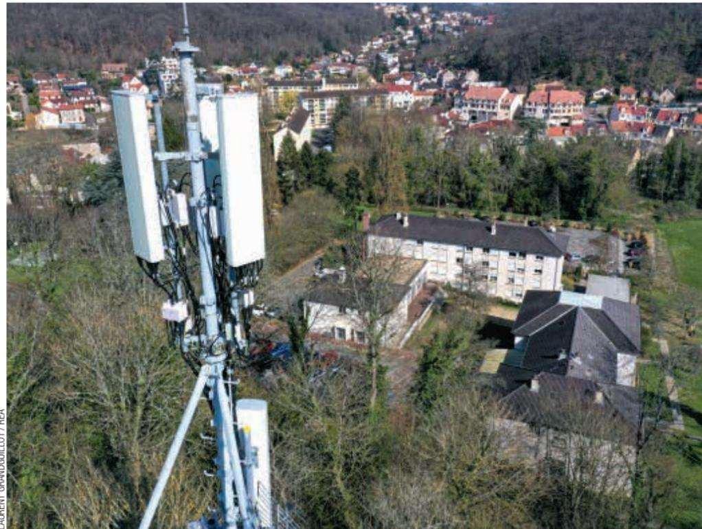
Les antennes 5G émettent un signal orienté de façon précise, et non dans toutes les directions comme dans la 4G. Là encore, l'Anses réclame un suivi de près à mesure du développement du parc.
